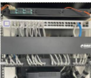
Para el mejor funcionamiento de las áreas ubicadas en los municipios de Macuspana, Comalcalco y Jalapa se hicieron cambios en los dispositivos de dispersión de red cuya tecnología resultaba obsoleta y fueron remplazados por un switch de última generación, evitando posibles fallas de comunicación en los bus de datos para la distribución de estos. Con esta mejora se aumentó la velocidad de conectividad de 10 mbps a 1 gbps por segundo, mejorando la
